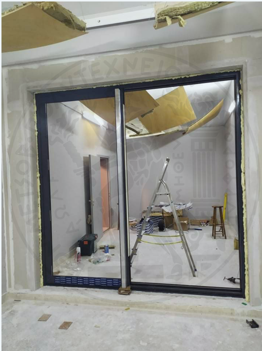
Πλαίσιο + σταθερό τμήμα ( Όψη από θάλαμο λήψης )
